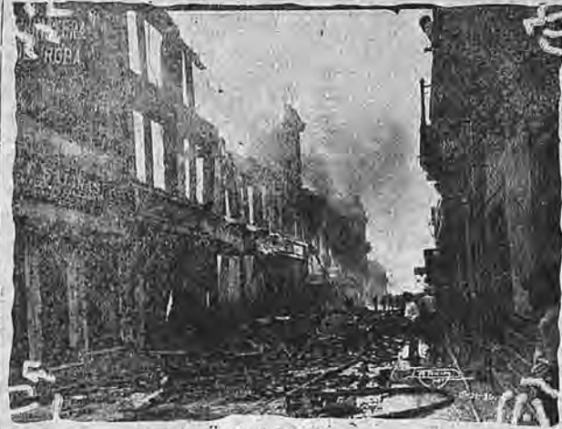
El edificio de "Sorpresa y Primavera" reducido a cenizas por el fuego. El incendio se inició en el primer piso y se propagó rápidamente.
