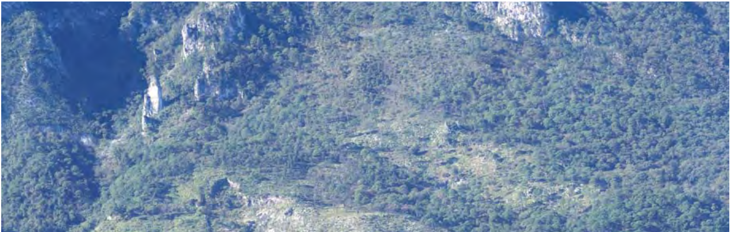
En esta toma de octubre de 2007, se muestran los trabajos de recuperación.
