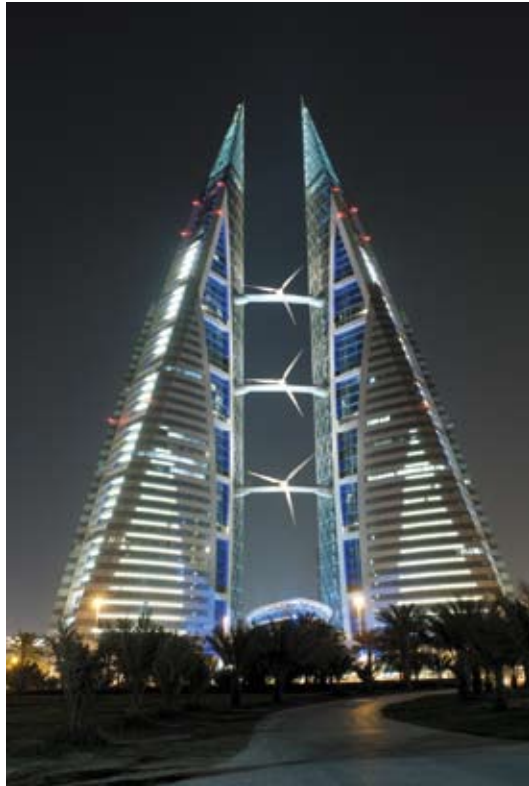
Este edificio ubicado en la ciudad de Manama, capital de Bahrein, suministra energía para su propio consumo a través de enormes turbinas de viento.
