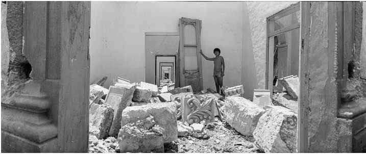
Imagen 3. Fausto Tovar Martínez, Demolición de un inmueble para la construcción de la Gran Plaza , Monterrey, Nuevo León, México 1981-1982. Procedencia: Fototeca Nuevo León-CONARTE © Fondo Fausto Tovar.
