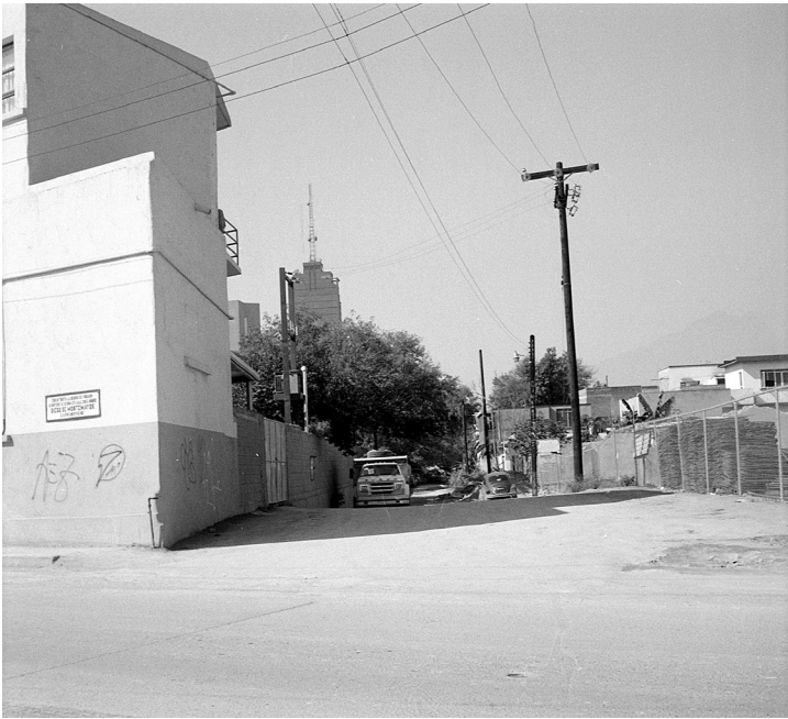
El desnivel que se observa en esta bocacalle correspondía con el área de la antigua presa de La Purísima. Imagen 6. Alberto Flores Varela, Calle contemplada dentro del Proyecto Santa Lucía (calle privada entre Juan Ignacio Ramón y 15 de Mayo sobre Diego de Montemayor), Monterrey, N.L., Ca. 1992. Procedencia: Fototeca Nuevo León-CONARTE © 9270 Fondo Alberto Flores Varela.
