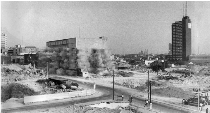
Imagen 13. Autor no identificado, “Demolición del edificio Roberts”, Monterrey, Nuevo León, 14 de agosto de 1982. Procedencia: Fototeca Nuevo León-CONARTE © Fondo AGENL.
