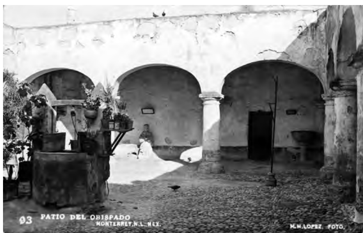
Imagen III.5 Manuel M. López, Patio del Obispado, vista de la cara sureste, Monterrey, Nuevo León México, 1940. Procedencia: Fototeca Nuevo León CONARTE
