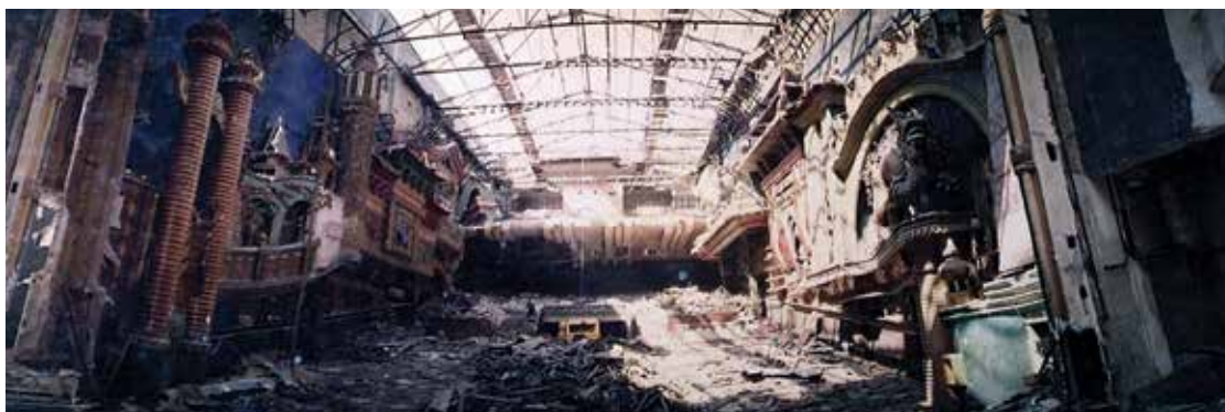
Dos vistas del interior del Cine Elizondo en pleno proceso de demolición.
