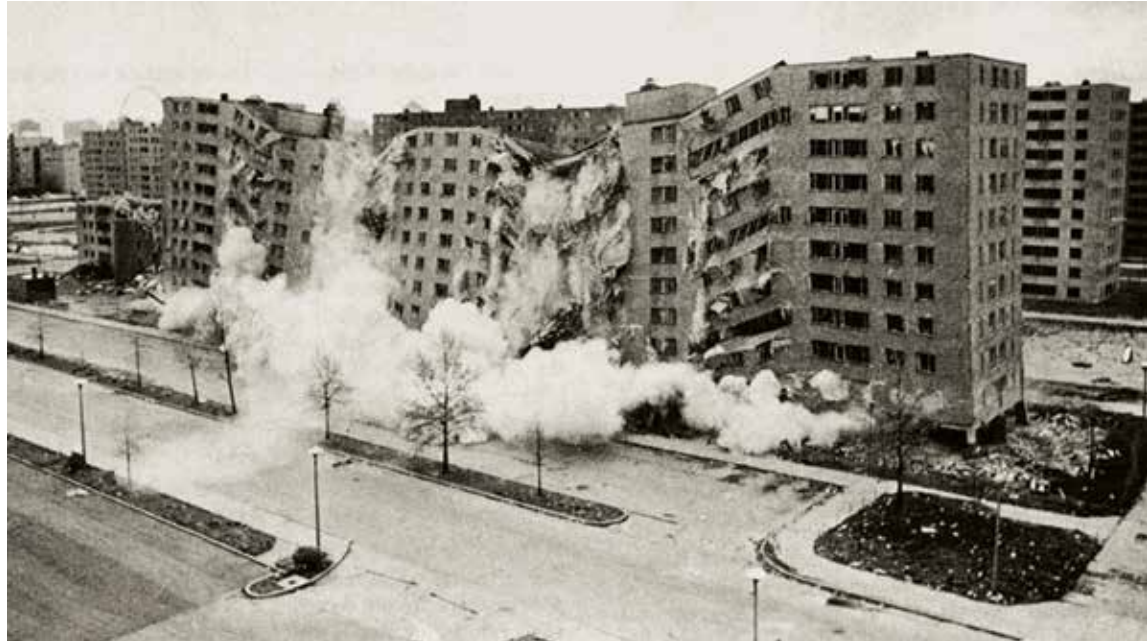
Demolición del conjunto habitacional Pruitt-Igoe (1952-55), en San Luis, Missouri, en 1972.
